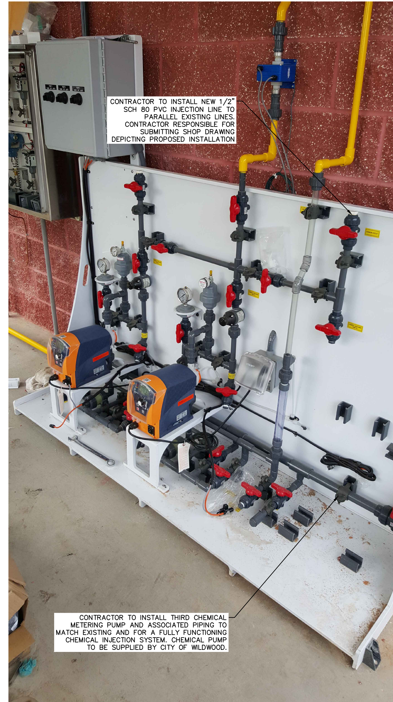
EXISTING CHEMICAL SKID N.T.S.
